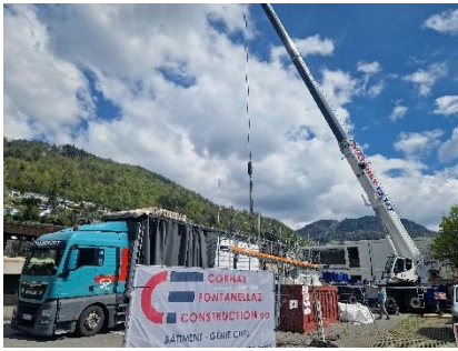
Construction du bâtiment provisoire
